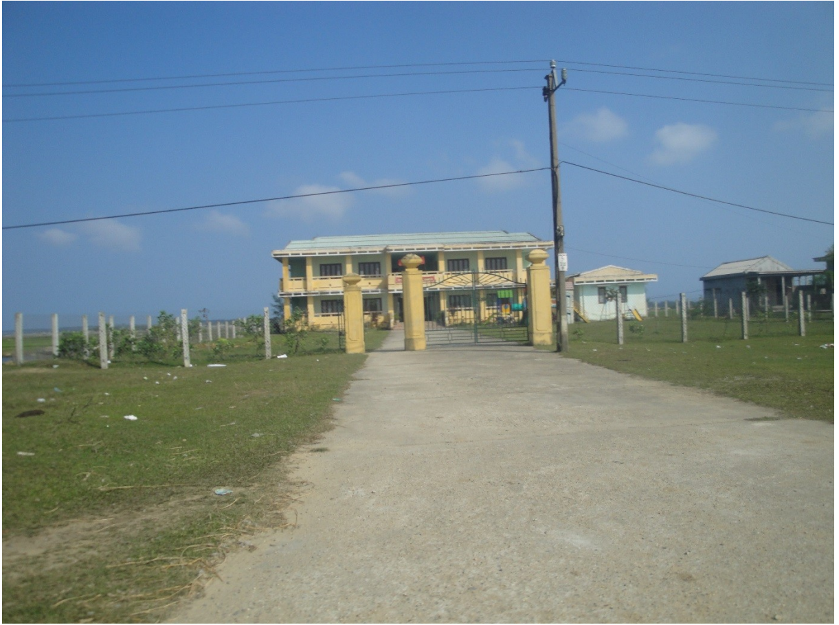
Hình i.6: Trường học được xây dựng kiên cố kết hợp làm khu vực tránh lũ cho nhân dân
