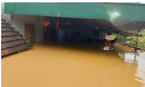
Hình ảnh về mưa lớn, lũ, ngập lụt
