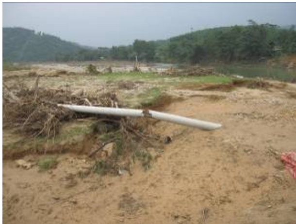
Hình 27. Lũ quét phá hủy hoàn toàn hệ thống dẫn điện xã Sơn Kim 2 – Hương Sơn
