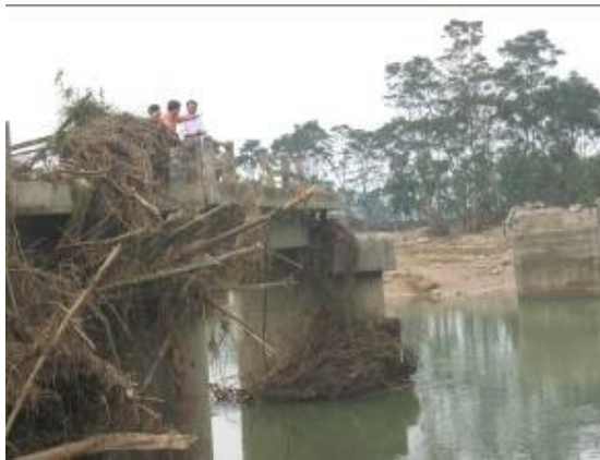
Hình 3.10. Cầu Đá Đón bị gãy (trái), cầu tạm (phải) cho người dân qua lại
