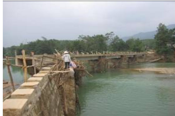
Hình 3.9. Cầu Khe Lành, xã Sơn Kim 2 bị lũ cuốn, gãy nhịp (trái) và người hình ảnh người dân đi qua cầu (phải)
