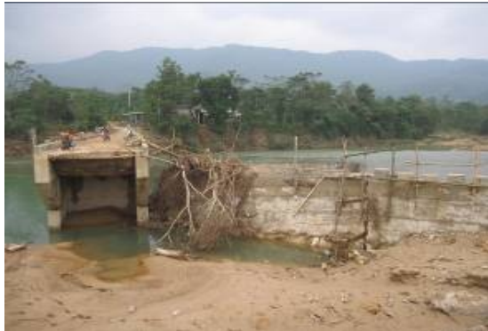
Hình 3.9. Cầu Khe Lành, xã Sơn Kim 2 bị lũ cuốn, gãy nhịp (trái) và người hình ảnh người dân đi qua cầu (phải)
