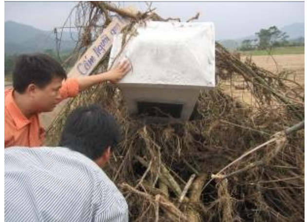
Hình 26. Tháp báo lũ quét gần Cầu Khe Lành bị nước lũ phá hủy tại xã Sơn Kim 2 – Hương Sơn
