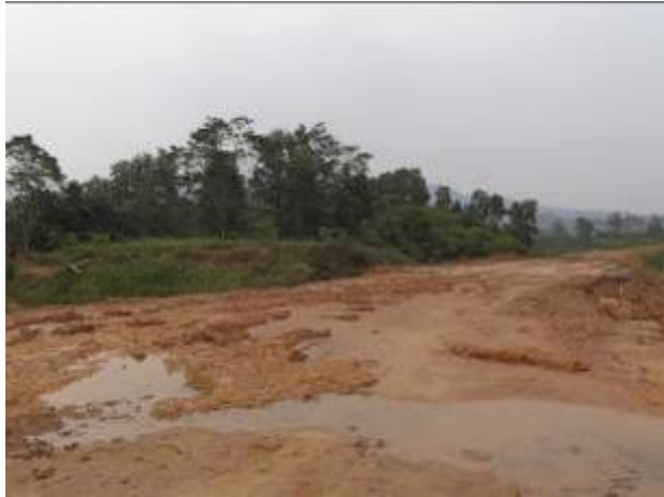
Hình 25. Nước lũ làm hệ thống giao thông tại xã Sơn Kim 2 tê liệt hoàn toàn
